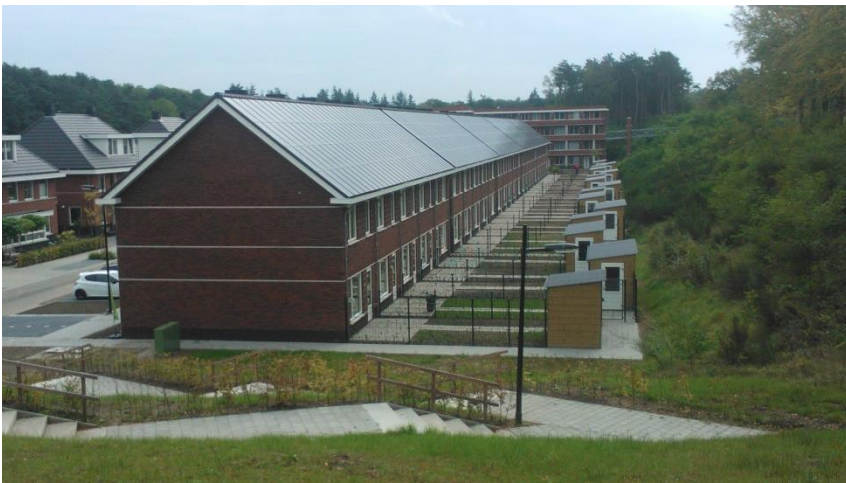
Energienota nulwoningen in de wijk Sterrenberg, Huis ter Heide. Door bij de bouw al direct te kiezen voor zonnepanelen, kunnen ze efficiënt geplaatst worden.
